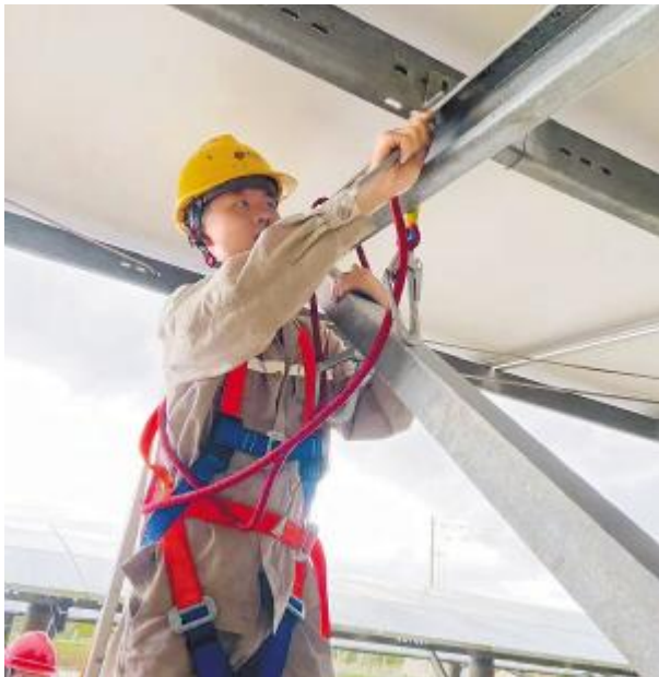
通威福清“渔光一体”电站运维人员紧固螺栓
